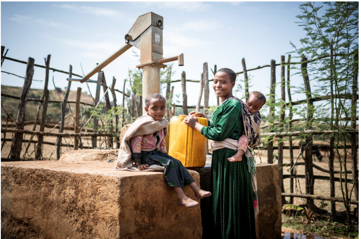
Der Brunnen mit Handpumpe versorgt 12 Familien mit sauberem Trinkwasser. Er ist durch einen Zaun vor Tieren geschützt.
