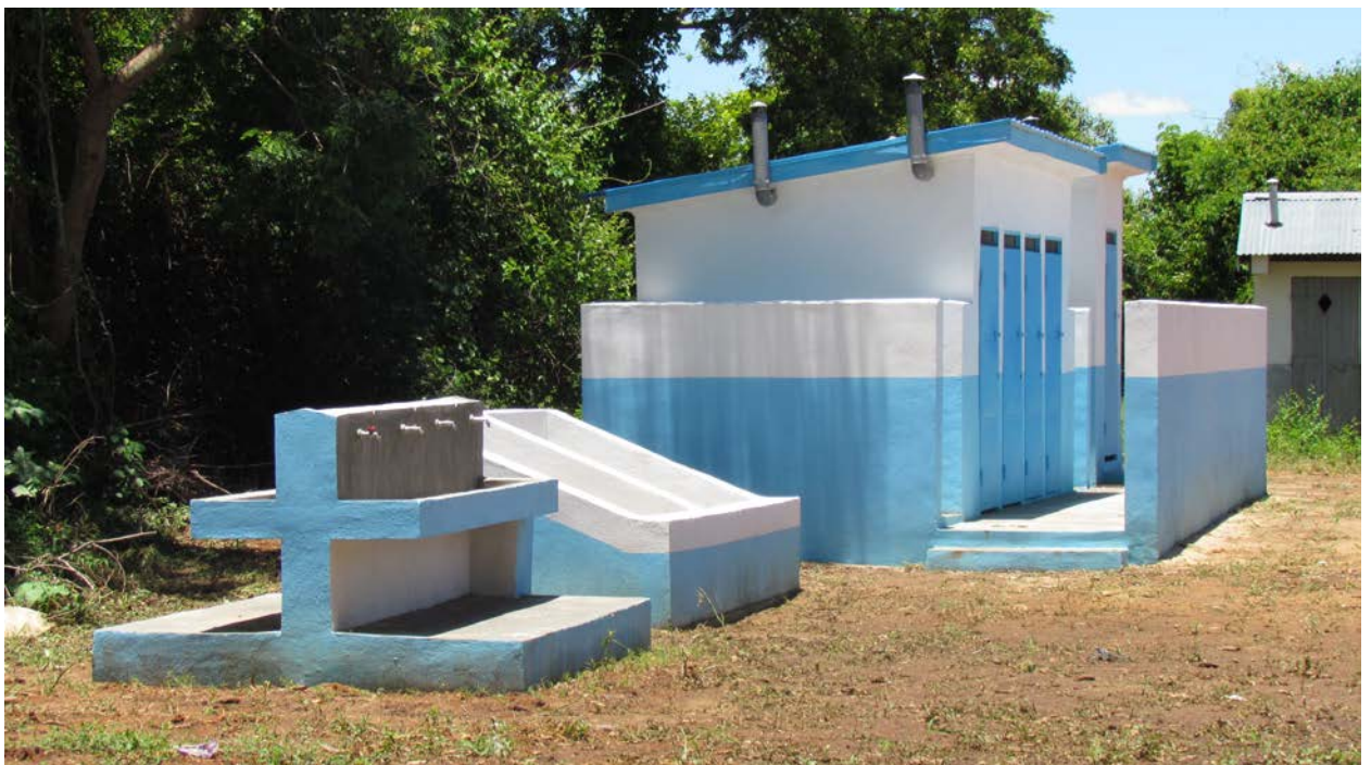
Handwaschstation mit 8 Hähnen und Latrinen an der Schule Ambatolahy
