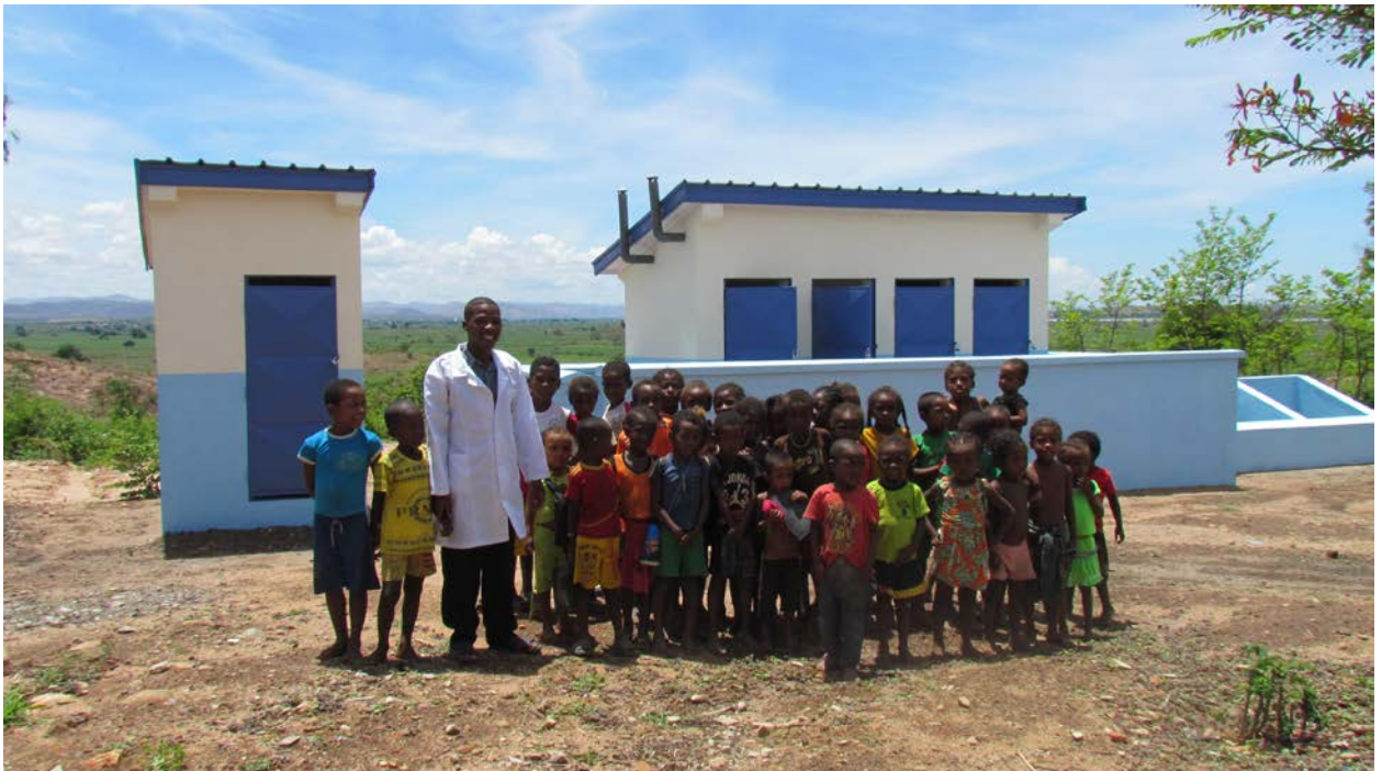
Lehrer mit seiner Klasse vor der sanitären Anlage der Schule Bepeha: links: Dusche, 4 Latrinen. Das Handwaschbecken ist mit den 8 Hähnen ist links (nicht im Bild, auf Bild Seite 6)
