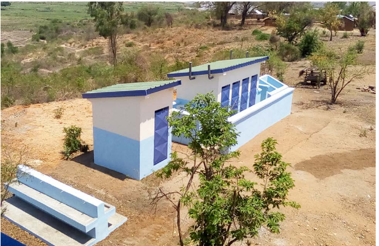
Wasseranlage von Bepaha: Waschbecken mit 8 Hahnen, Dusche, Latrinen
