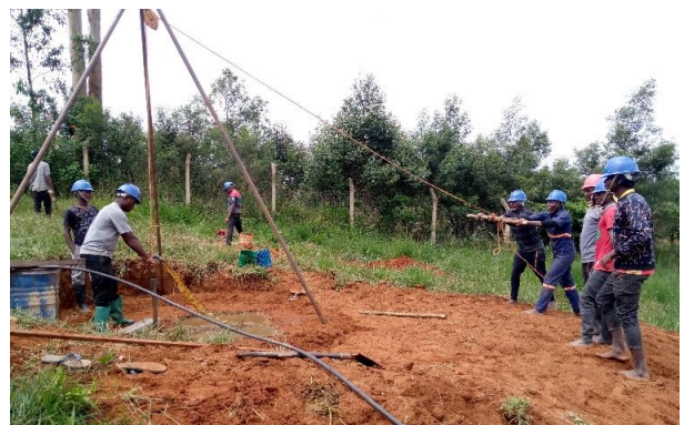
Ein Bohrloch wird vorbereitet (links) und mit manuellen Techniken gebohrt (rechts). Anstelle von mechanis Bohrtechniken, die sehr teuer sind, kommt so viel Handarbeit und Erfahrung zum Einsatz – zum Gewinn von allen. (© SHIPO)
