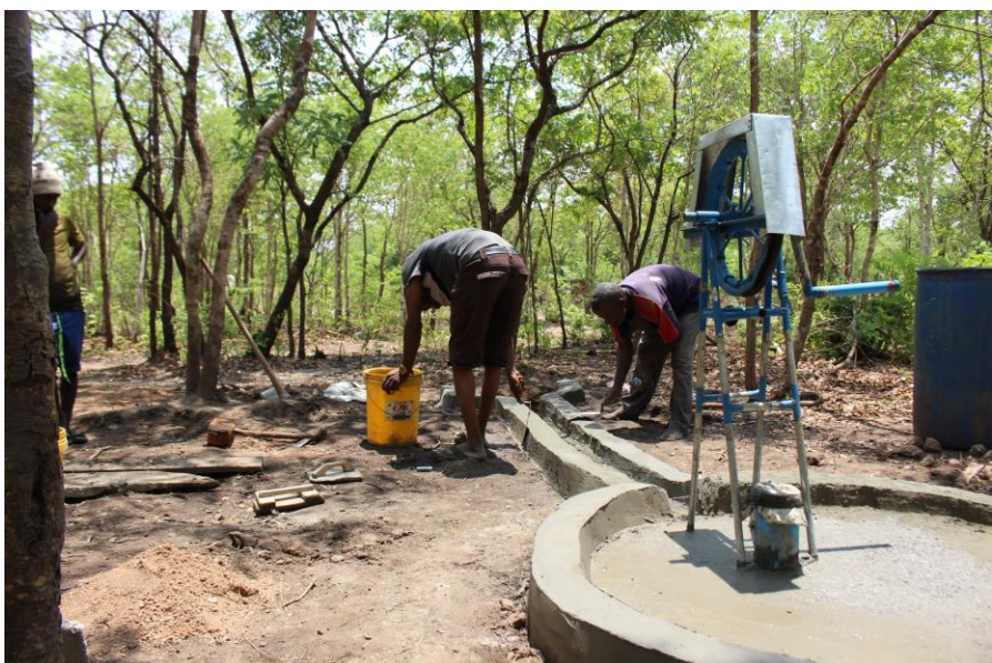
Die ausgebildeten Handwerker bei Fertigstellen des Bohrlochs (© Jacana)
