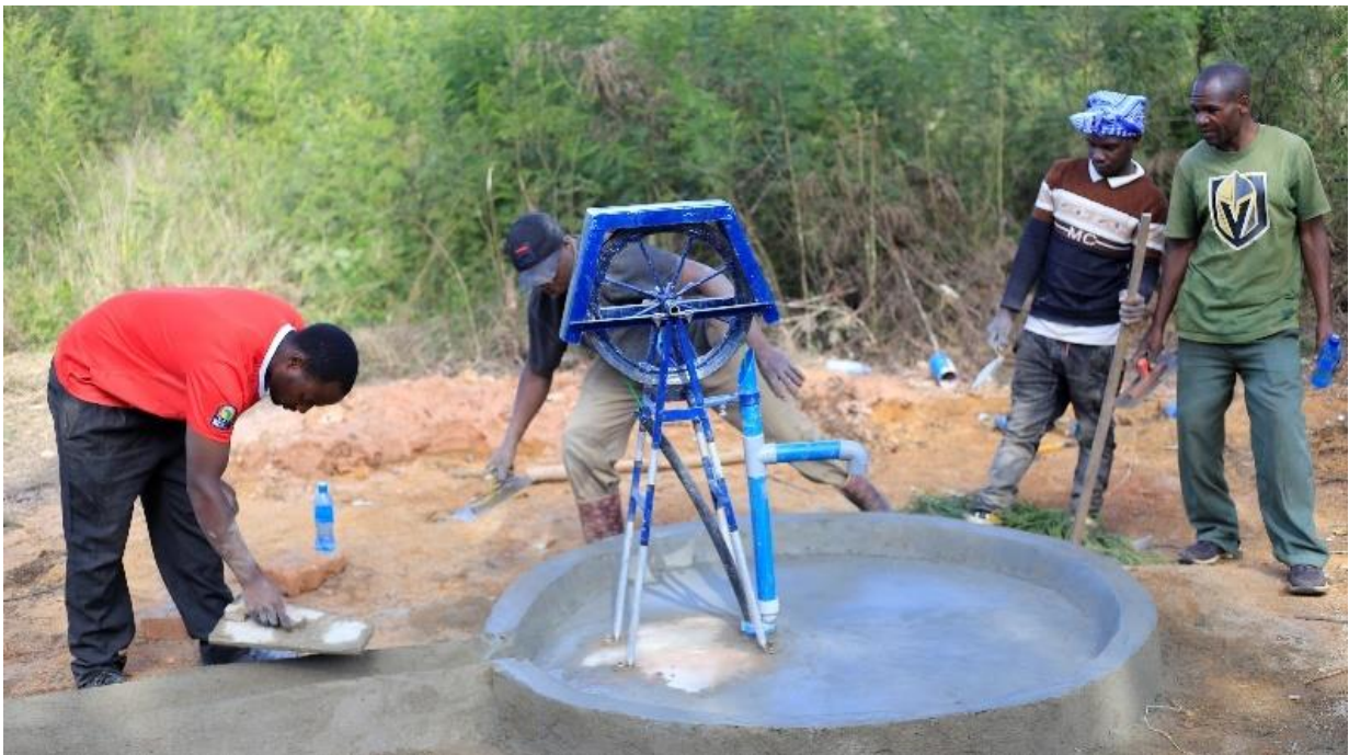
Die Teilnehmer der Trainings lernen, eine «Rope Pump» auf einem Bohrloch zu montieren und dieses mit einem Deckel und Abfluss vor Verschmutzungen zu schützen. Diese Elemente werden später auch bei den neu installierten Bohrlöchern von SHIPO überprüft. (© SHIPO)
