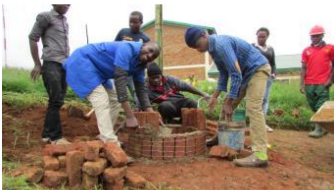
Teilnehmer beim Bau eines Wassertanks während des Trainings
