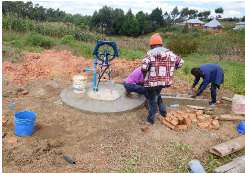
Handwerker installieren ein Bohrloch mit Handpumpe
